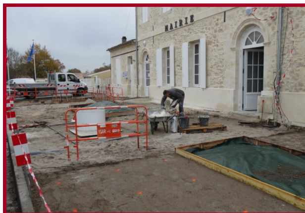
Construction du puits
