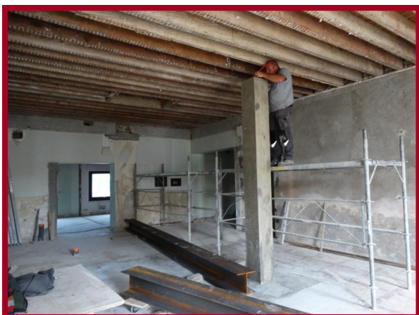
Début de la réhabilitation
