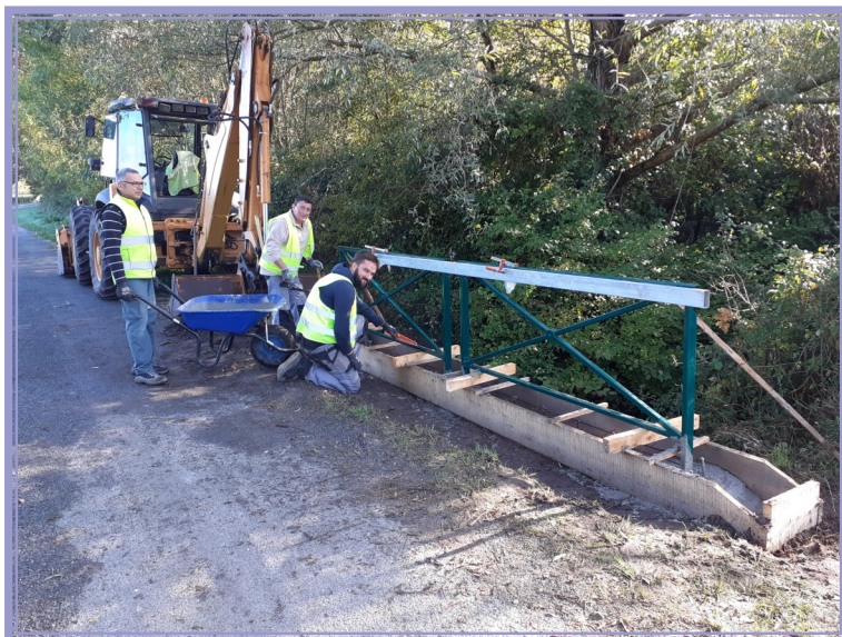
Pose de barrières de sécurité sur le ruisseau de Larreyaut. (route de Peyvignau)
